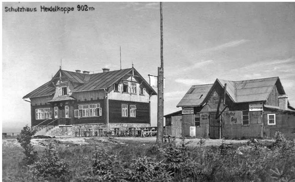
Schronisko na Borówkowej (po lewej) wraz z budynkiem gospodarczym
